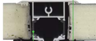
Профили без температурного моста
